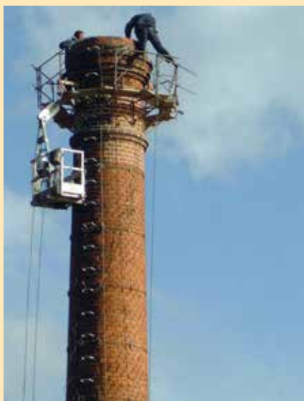
Restauratie van de schoorsteen
